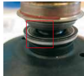
Accumulation de la pâte à joint dans l'ensemble presse étoupe
